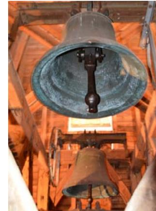
Die Klöppel der drei Glocken müssen erneuert werden; die Aufhängung der Glocken (bisher aus Eisen) muss durch Eichenjochen ersetzt werden; außerdem müssen die vorhandenen Läutemaschinen auf elektronische Steuerung umgebaut werden.“
