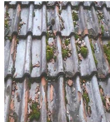
Stark beschädigte Dachziegel, fehlende Abdichtung, schlechte Isolierung – so das Fazit der Baubegehung des Dachs über dem Gemeindehaus der Gnadenkirche. Bevor der Frost die Dachziegel noch mehr aufsprengt, Wasser eindringt und Schaden am Gebäude entsteht, muss das Dach dringend saniert werden.
